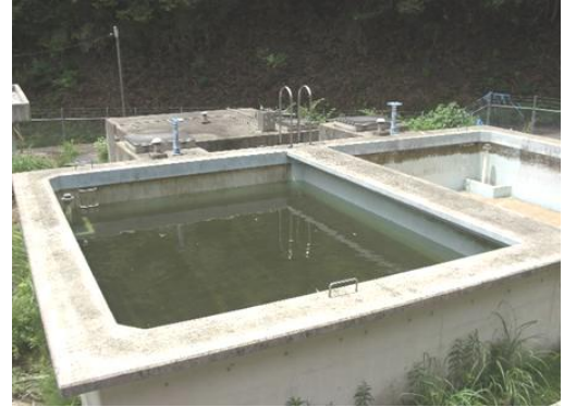
北東部浄水場
