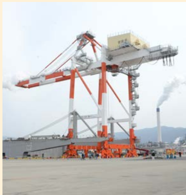
▲三島川之江港に設置されたガントリークレーン
