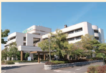
▲建設予定地となる三島医療センター
