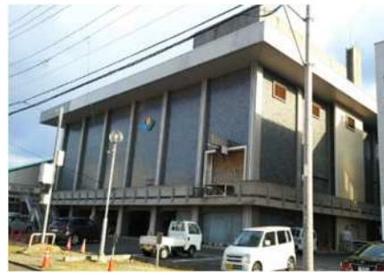
市民会館川之江会館 (老朽化)
