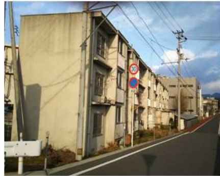
港通りアパート (老朽化)
