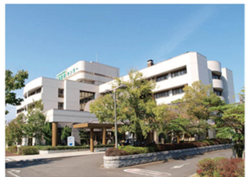
中核病院の建設予定地に決定した現在の三島医療センター
