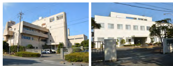
下水処理で生活環境を守る川の江・三島浄化センター
