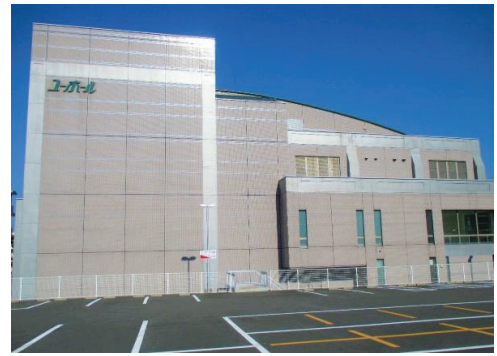
調査を行う土居文化会館
