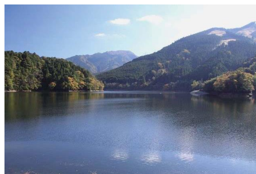
柳瀬ダム 平野橋付近
