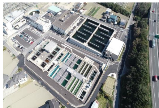
中田井浄水場
