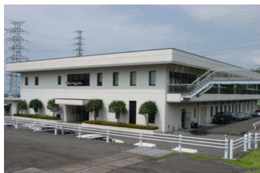
中田井浄水場 浄水管理センター
