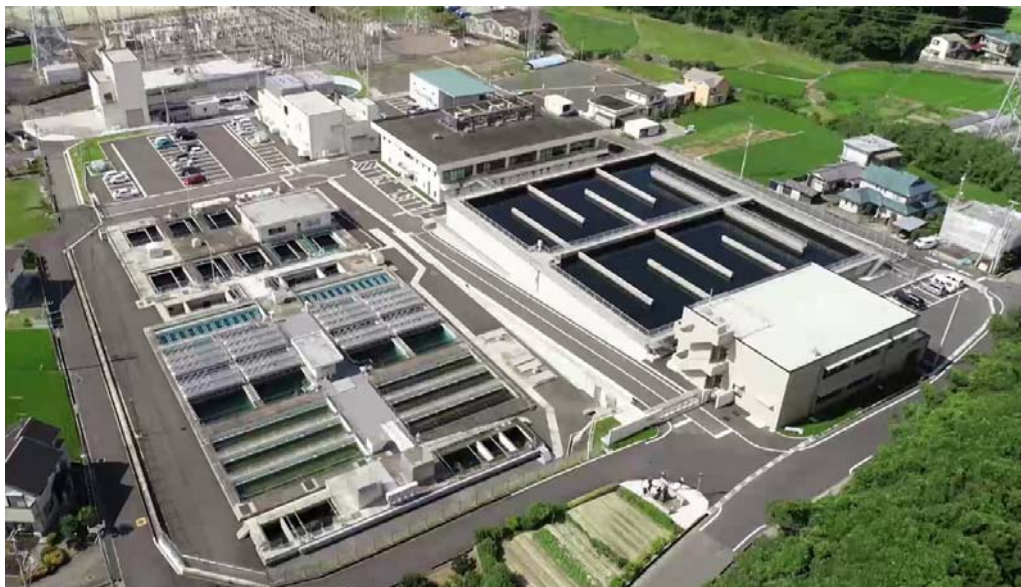
中田井浄水場
