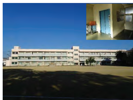
改修工事を予定している三島小学校
