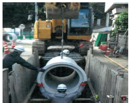
雨水管の設置状況
