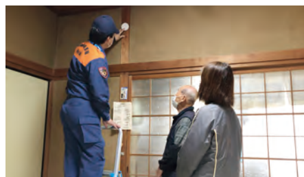
住宅用火災警報器の設置・点検
