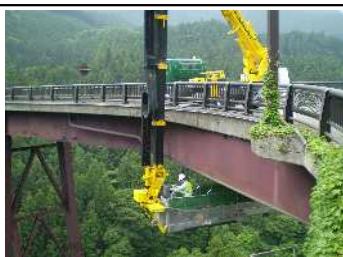
図3.2 橋梁点検車による点検風景
