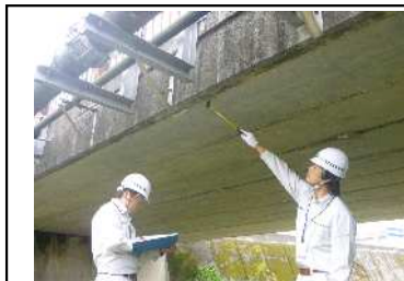
図3.1 定期点検の様子
