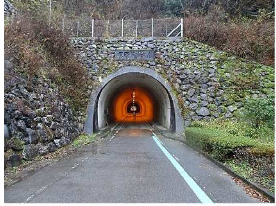
写真 2.2 藤原トンネル
