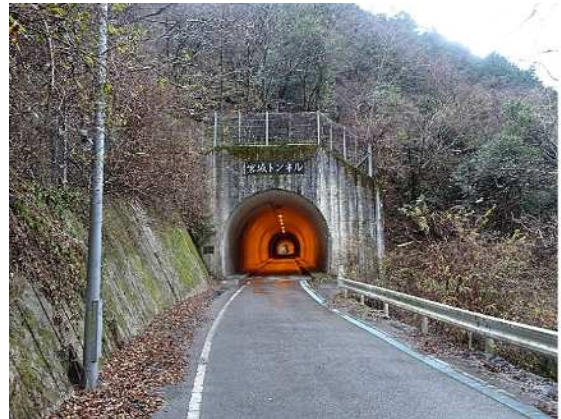
写真 2.4 宮城トンネル
