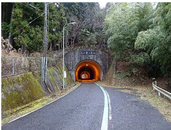
写真 2.5 葛川トンネル
