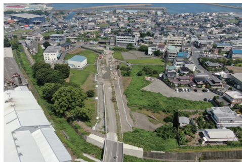
整備工事が進む寒川中央線（令和5年9月撮影）
