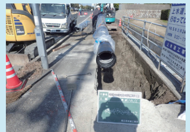
大規模地震に備え、重要給水施設管路の耐震化に取り組んでいます。
