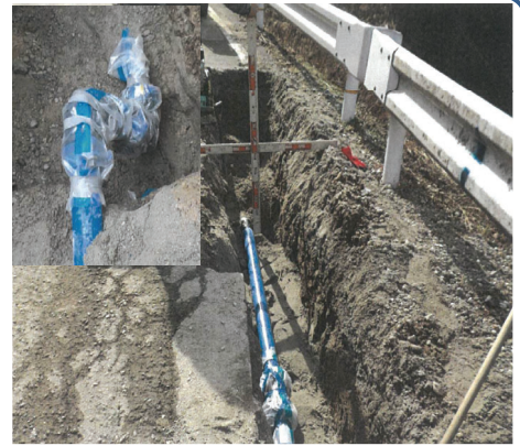
(水道管布設の様子)
