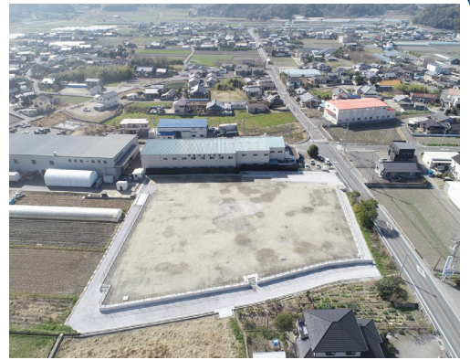
(土居町蕪崎の建設予定地)
