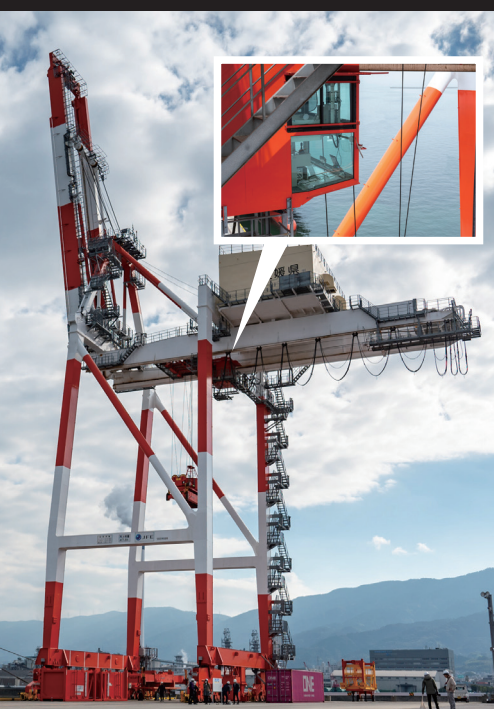
▲ 空中の運転室から操作する
