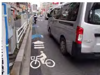
写真 I-5 車道左側部の車線内に矢羽 根型の路面表示を設置した事例（歩道 のある道路）
