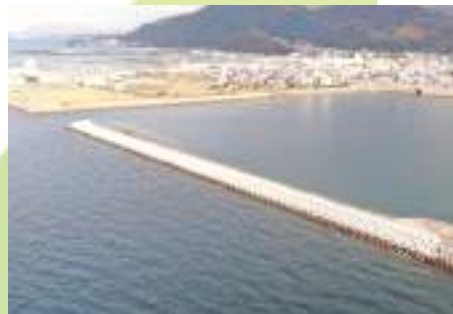
城山下臨海土地造成事業 (令和6年12月10日撮影 川之江町)
