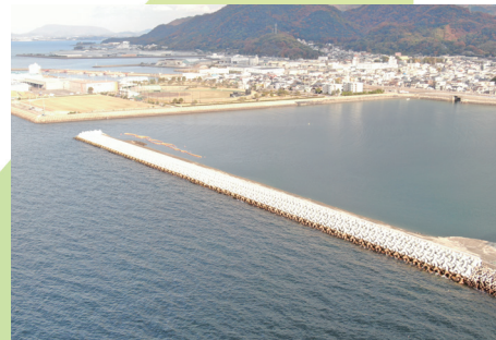
城山下臨海土地造成事業 (令和6年12月10日撮影 川之江町)
