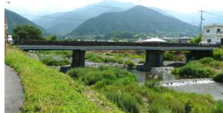
常盤橋（1959年架設→2015年補修）
