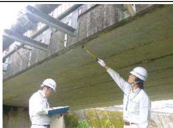
図3.1 定期点検の様子
