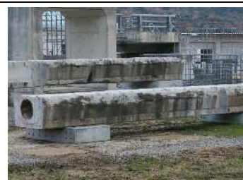
図3.3 四国技術事務所にて損傷桁の検証
