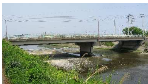
大江橋（1966年架設→2014年補修）
