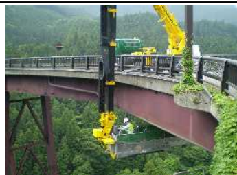
図3.2 橋梁点検車による点検風景
