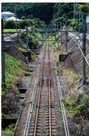
銃撃を受けた列車が走った線路。奥にトンネルがある（土居町北野）
