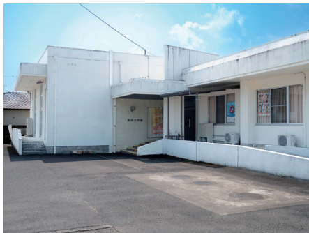
蕪崎公民館（昭和54年完成）
