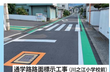
通学路路面標示工事(川之江小学校前)
