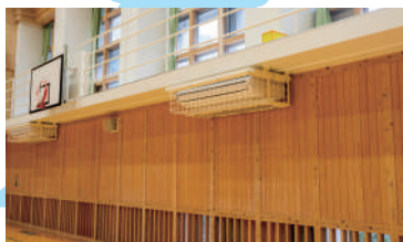
屋内運動場空調設備工事(新宮小・中学校)
