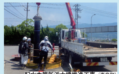
配水本管新浜大橋推進工事（妻鳥町）
