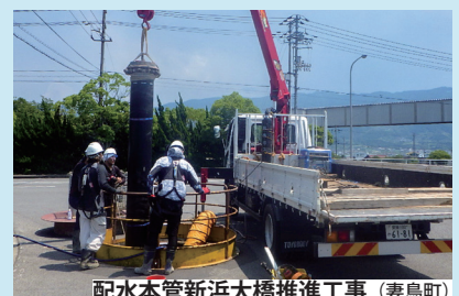
配水管本浜大橋推進工事（妻鳥町）
