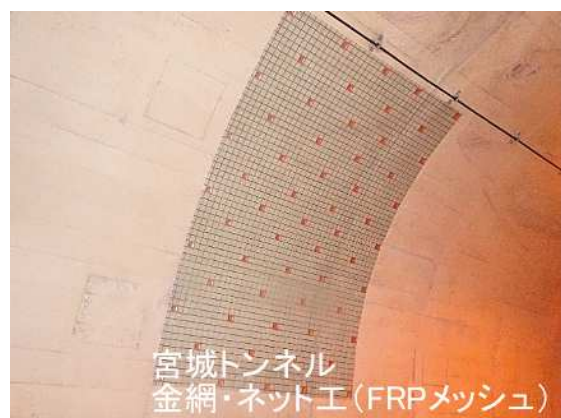
写真 3.3 補修対策事例
