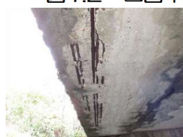
図1.3 コンクリート橋の損傷状況
