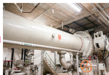
新宮ダムから取水した水は、最大直径2.4mの水圧鉄管を通して水車に送られる
