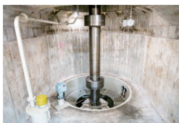
水の勢いを使って水車を回し、回転力に変える
