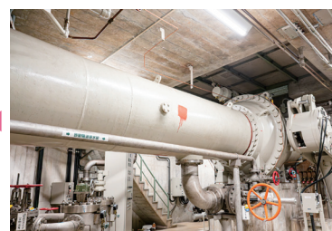
新宮ダムから取水した水は、最大直径2.4mの水圧鉄管を通して水車に送られる
