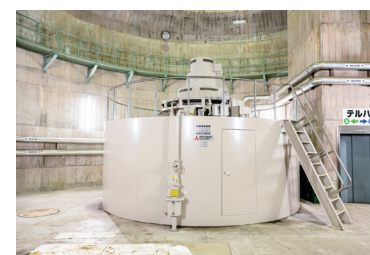
回転力を発電機で電気に変える
