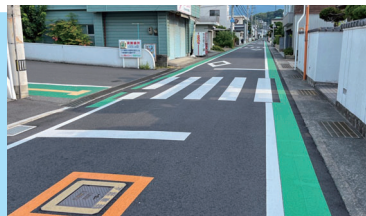
通学路路面標示工事(川之江小学校前)
