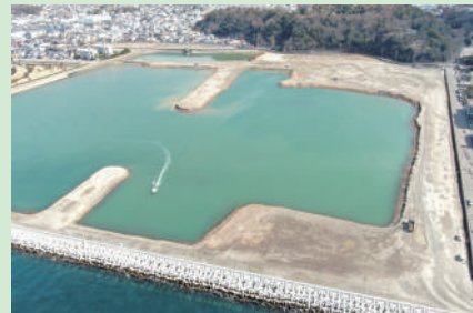
城山下臨海土地造成事業 (令和8年3月撮影)
