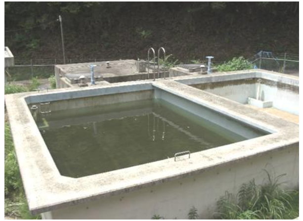
北東部浄水場
