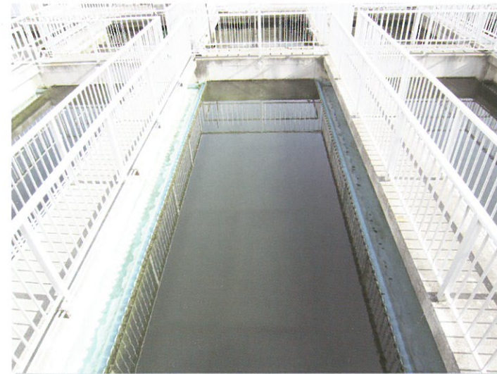
最終沈殿池(川之江浄化センター)
