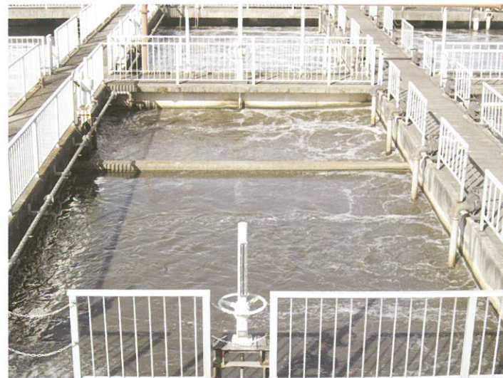
エアレーションタンク(川之江浄化センター)
