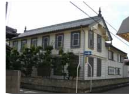
国登録有形文化財(建造物) [和田医院診療棟] 川之江町1746 明治末期の洋風医院建築
