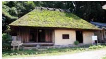
国指定有形文化財 (建造物) 「真鍋家住宅」 金生町山田井2030-2 17世紀中頃のものとして、地方の民家の祖形として重要
