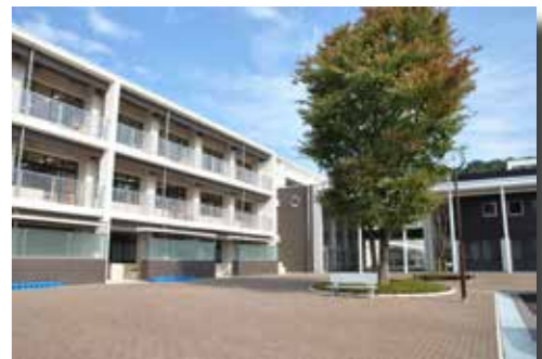
校舎や管理棟など、全面的な建て替えが行われ、平成23年6月に全工事が完了した川之江小学校
