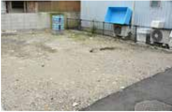
取り壊し後の敷地
