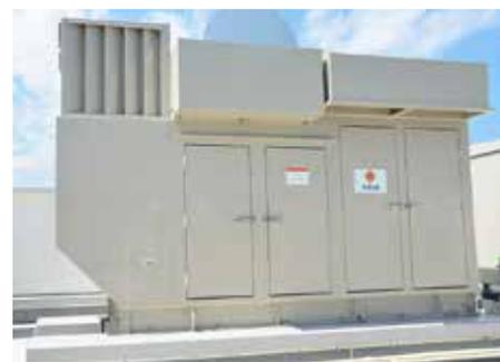
▲災害時に必要な電気を供給するための非常用自家発電設備
