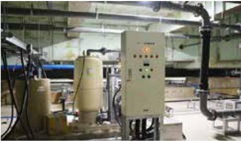
▲雨水を貯めてトイレ用水などとして使用するための雨水利用施設
