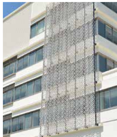
▲日射を抑制する水引きデザインをモチーフにしたアルミシェード
