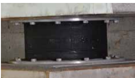
▲地震の揺れを低減する免震装置
