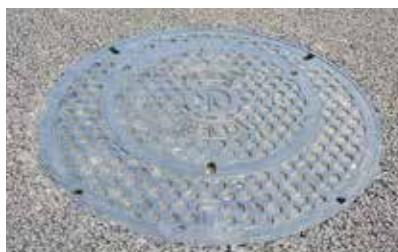
▲13,000 人分、40,000ℓ の飲料水を貯めることができる飲料水兼用耐震性貯水槽（地下に埋設）
