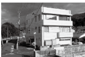
富郷配水管理事務所
