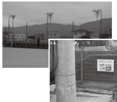
妻鳥小学校グラウンド (照明の改修)
