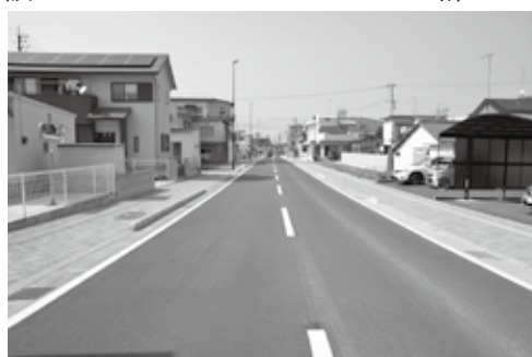
第2工区供用区間
