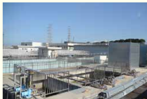
更新整備中の中田井浄水場
