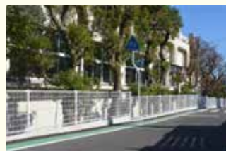
教育費 小・中学校ブ ロック塀・冷房 設備対策事業 (中曽根小学校)
