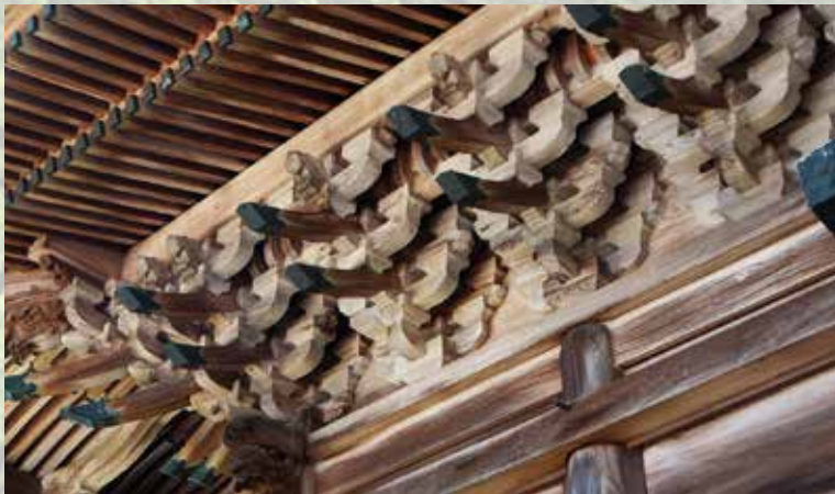
三手先の詰組が密に配された美しい構造。長い年月、軒をしっかりと支えてきた
