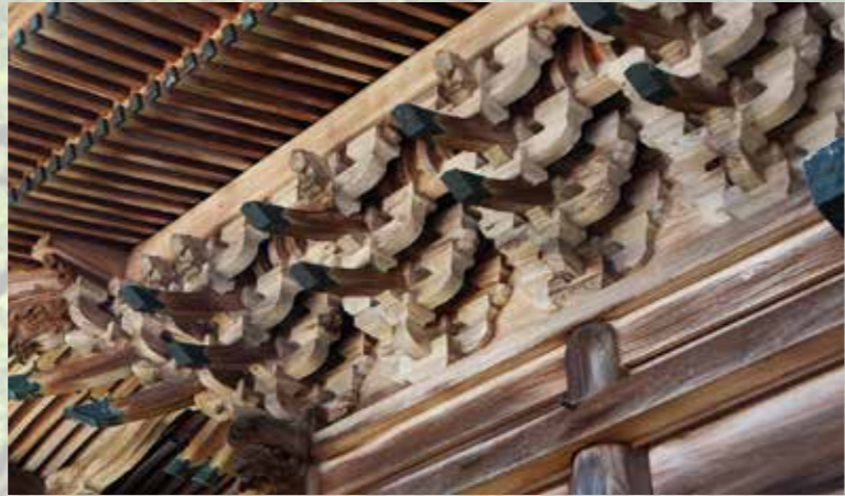
三手先の詰組が密に配された美しい構造。長い年月、軒をしっかりと支えてきた
