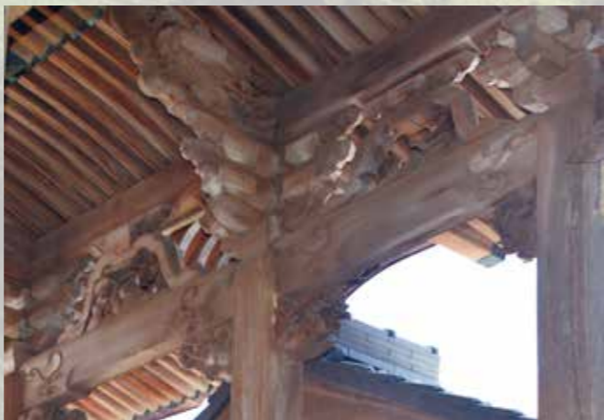
唐様の美しい彫刻が施された向拝軒下
