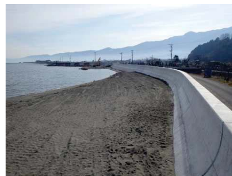
護岸整備が進む天満漁港付近の様子
