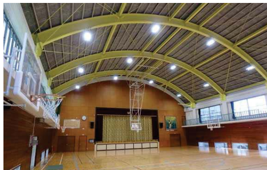
非構造部材耐震化の様子（金生第二小学校体育館）
