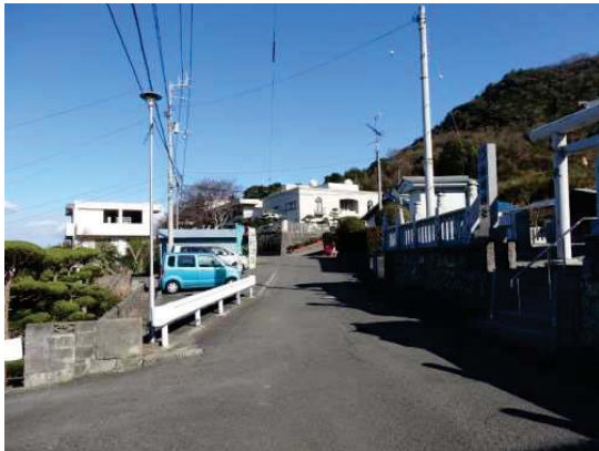
雨水排水路の整備を予定している川之江町長須地区
