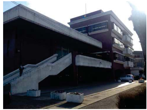
耐震改修工事を予定している川之江文化センター
