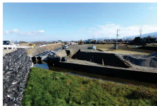
道路改良が進む下井手藤原海岸橋（土居町中村）
