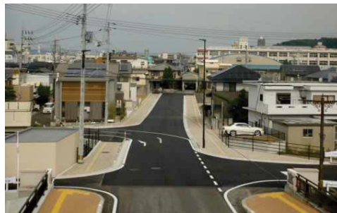
街路整備が進む塩谷・小山線 (川之江町金生橋付近)
