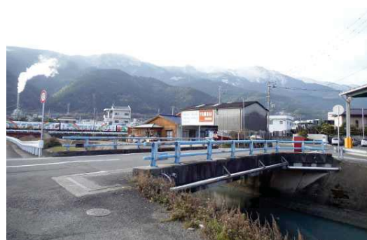
橋りょう補修工事を予定している静進橋（寒川町）
