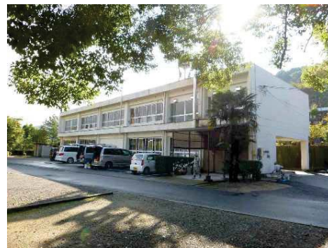
耐震改修工事を予定している老人福祉センター (上柏町)
