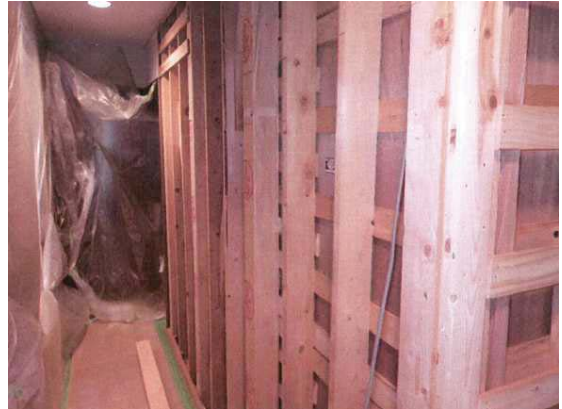
木造住宅リフォームの様子（平成28年度）
