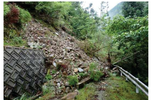
台風18号に伴う被災状況（林道寺成線）
