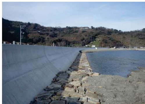
護岸整備が進む天満漁港付近の様子
